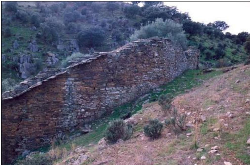
Muro Alto (Idanha-a-Nova). Aspecto da estrutura do muro, construído em encosta muito inclinada. É visível um trecho do beirado existente no topo do muro.
