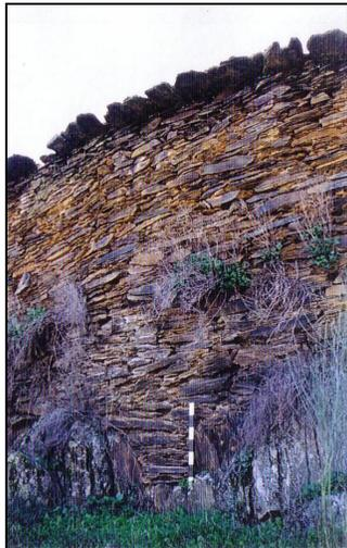
Muro do Vale do Gamo. Aspecto do assentamento da estrutura sobre afloramentos. No topo do muro pode observar-se o beirado.
