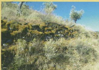
Fig. 3 - Vestígios de muralha aproveitada como muro de suporte de oliveiras (Henriques & Caninas, 2013)
