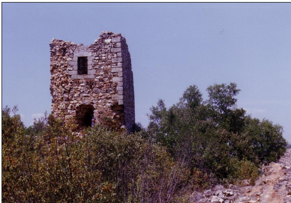
4. Vista da fachada sul do castelo onde se observa a porta (em cima), o buraco aberto na parede da torre e o estado de degradação dos cunhais, especialmente o que está virado a sudoeste.
