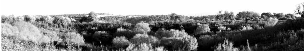
Fig. 13 - Vista ao nível do solo da barragem da Granjinha do Meio.
