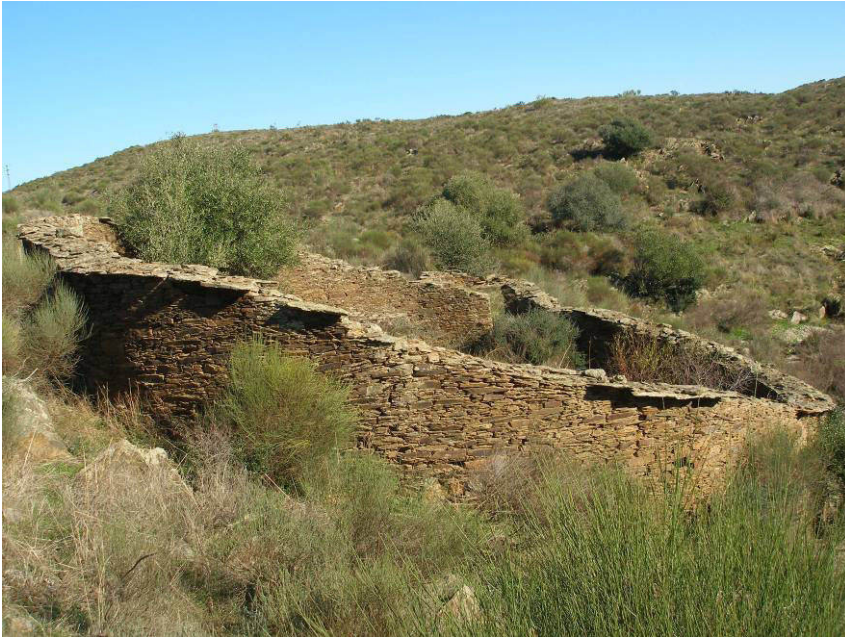
Figura 11. Muro del Carrascal (Alcántara), donde se observa el voladizo de pizarra para impedir los asaltos al interior.
