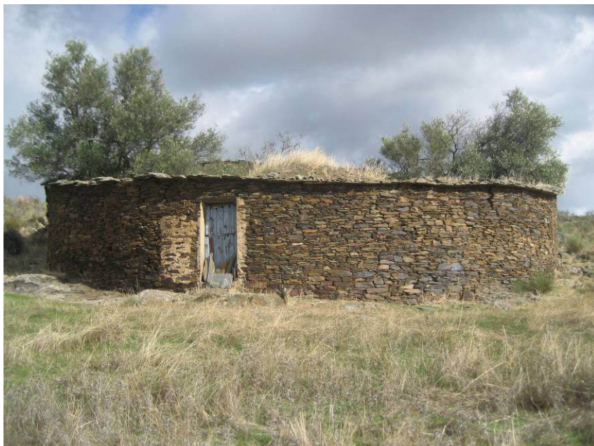
Figura 4. Muro de colmenas localizado en Tajo Internacional (Alcántara).
