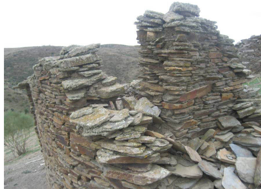
Figura 10. Muro de los Cercados de la Cagona (Alcántara), donde se observa la altura y el grosor de los tapiales.
