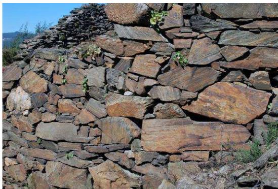
**Figura 6.** Paramento do Muro 1 de Paradela, em xisto, com pedra assente a seco.
