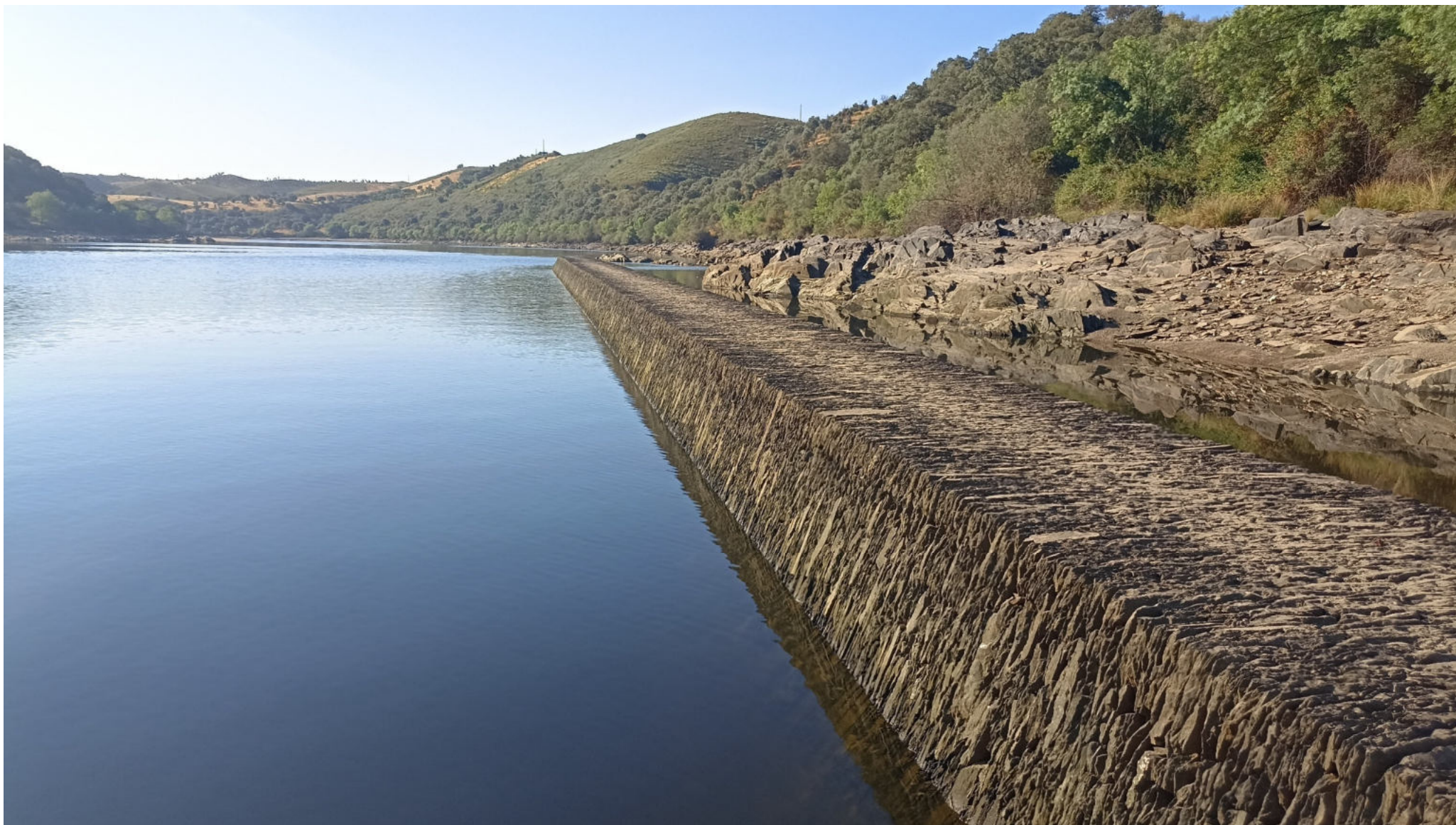
Figura 12. Perspetiva do muro de jusante para montante.
