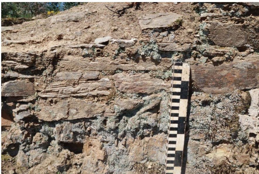
Figura 21. Um detalhe da alvenaria dos muros.
