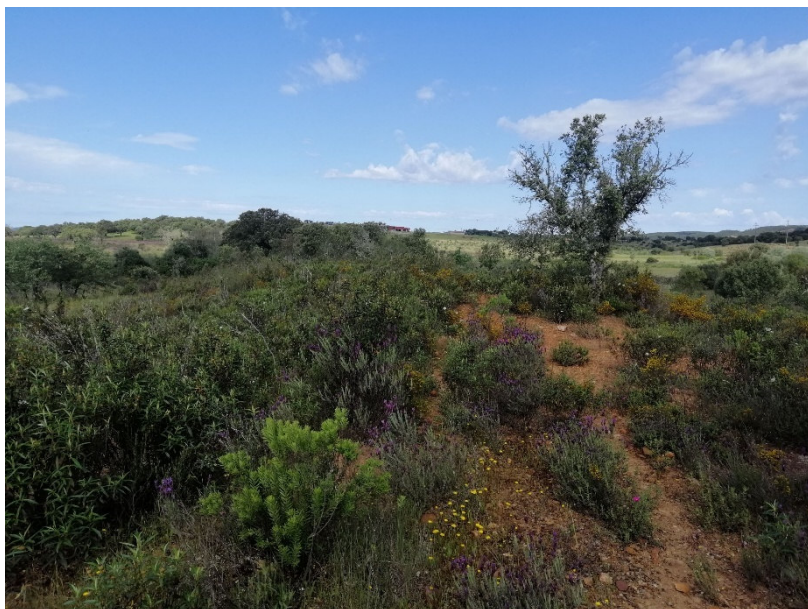
Figura 7. Aspeto do encontro oriental da barragem
