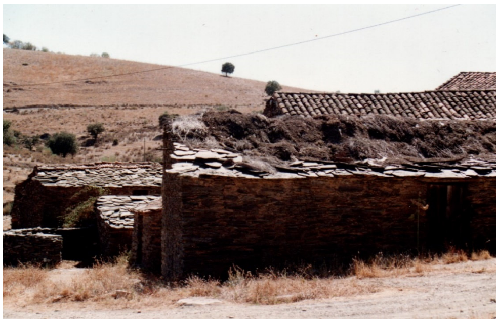
Figura 6. Cobertura de palheiras nas Soalheiras, em colmo, xisto e telha. Uma sucessão no tempo.
