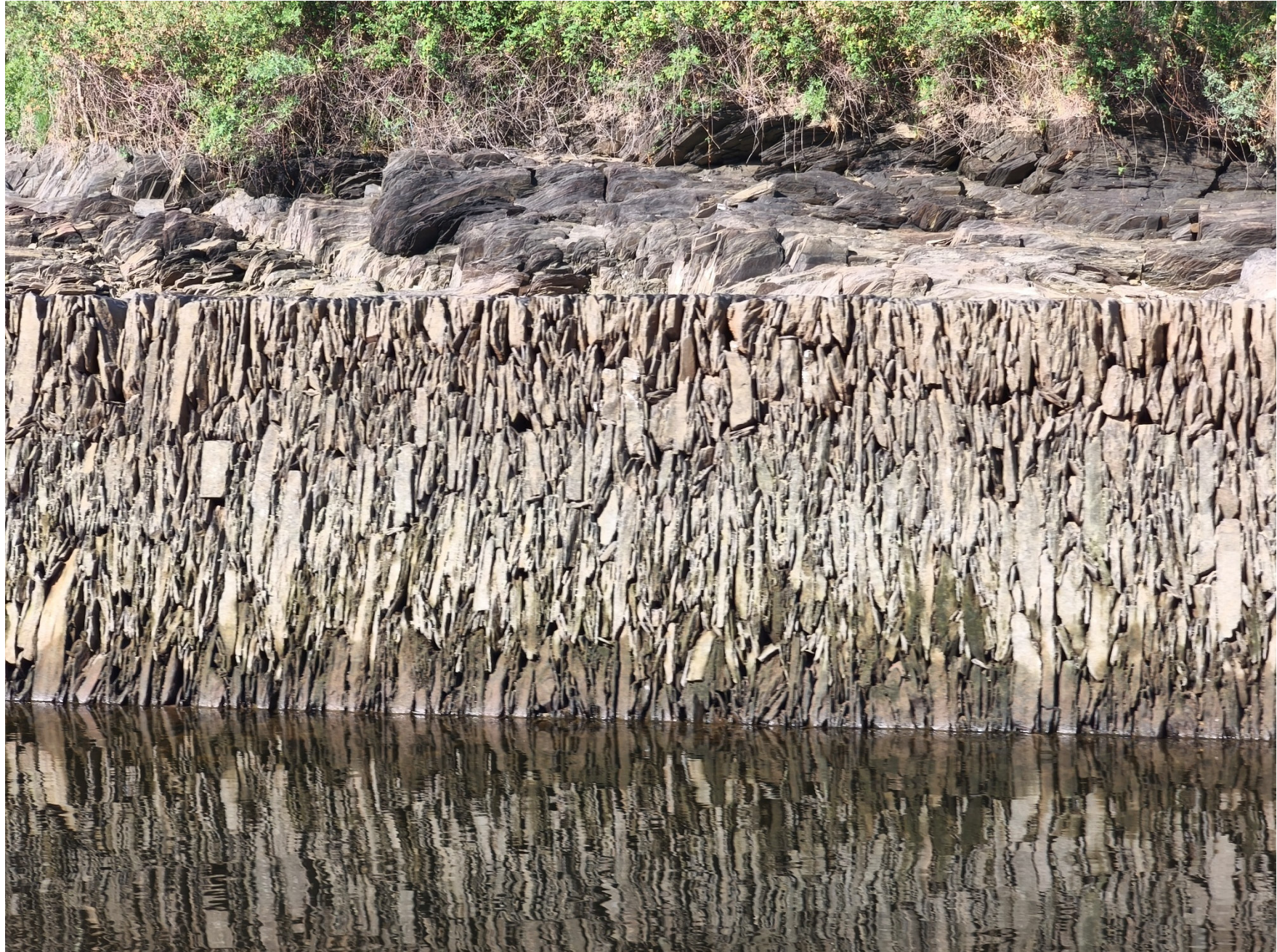
Figura 3. Tipologia construtiva do muro de sirga: técnica de carril ou em escama.
