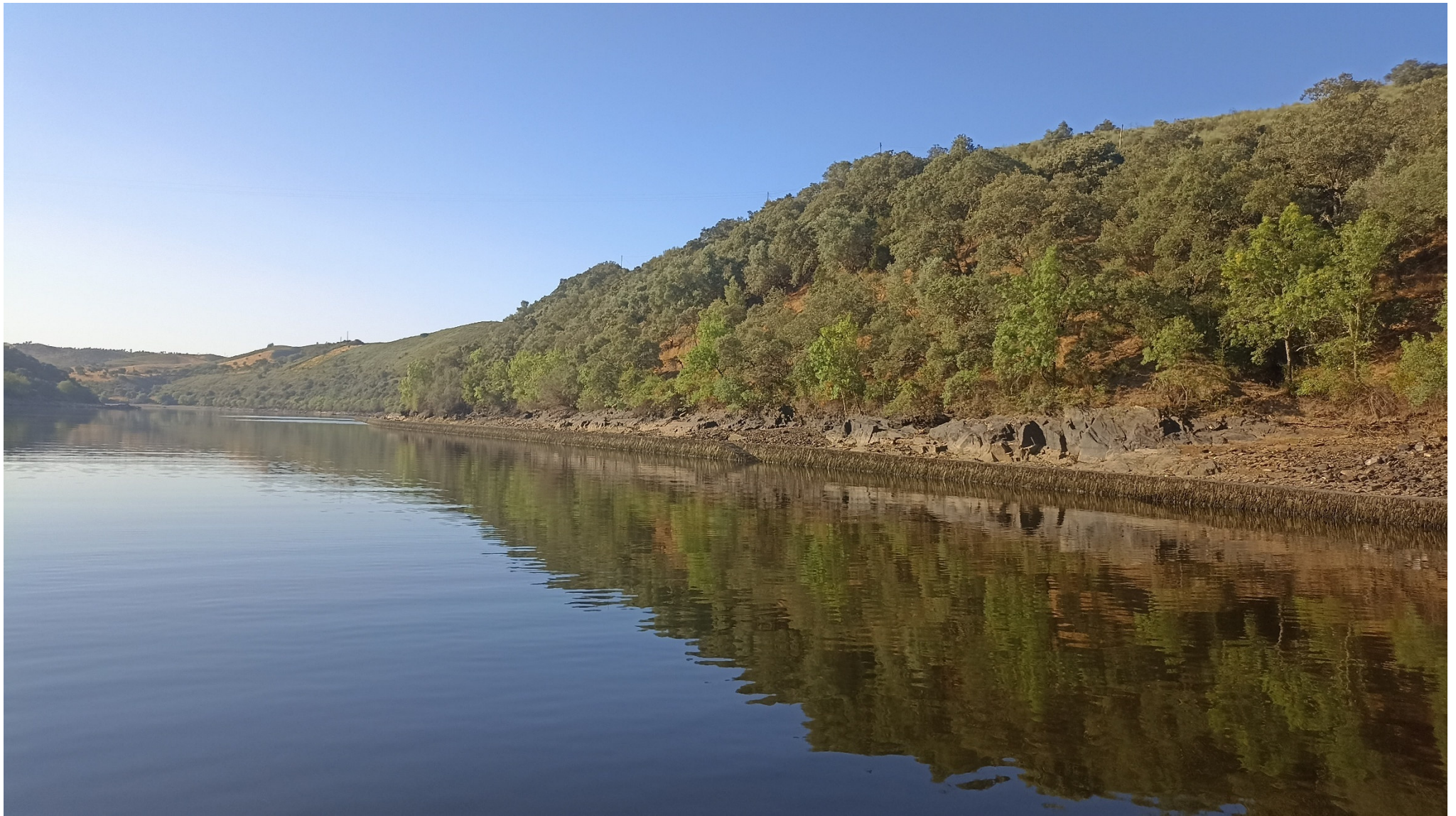
Figura 9. Vista do muro a partir do rio de jusante para montante.
