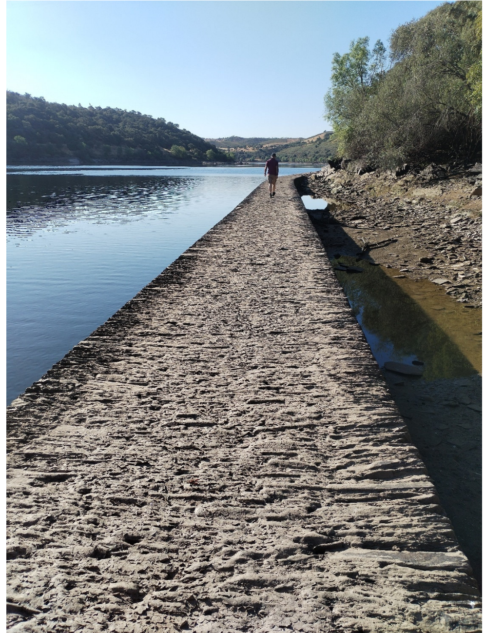
Figura 5. Outra perspetiva da estrutura vista de jusante para montante.
