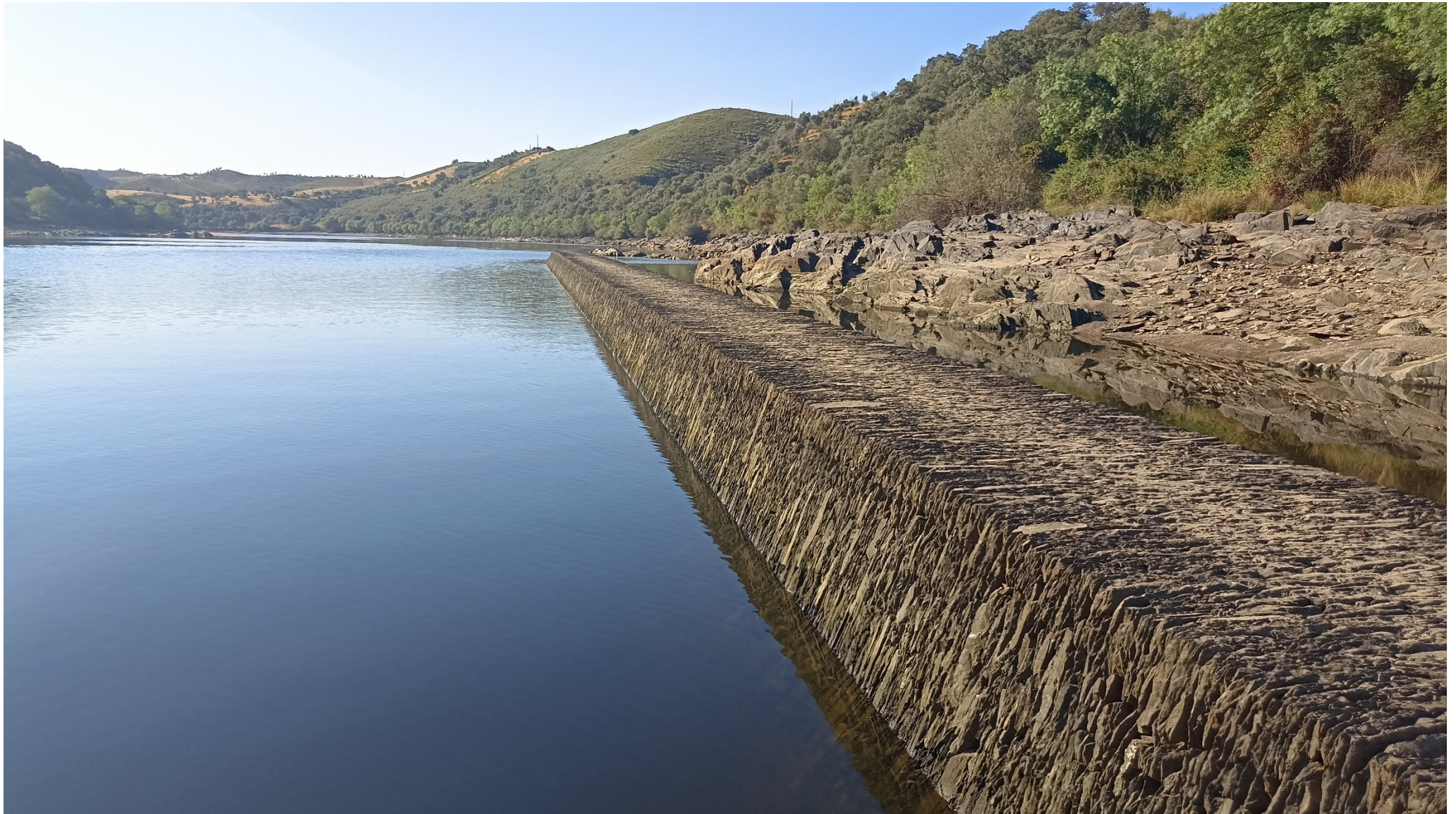
Figura 12. Perspetiva do muro de jusante para montante.
