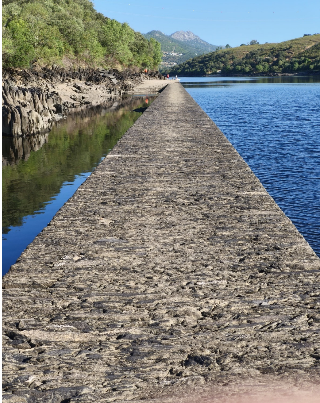
Figura 8. Outra perspetiva do muro vista de montante para jusante.
