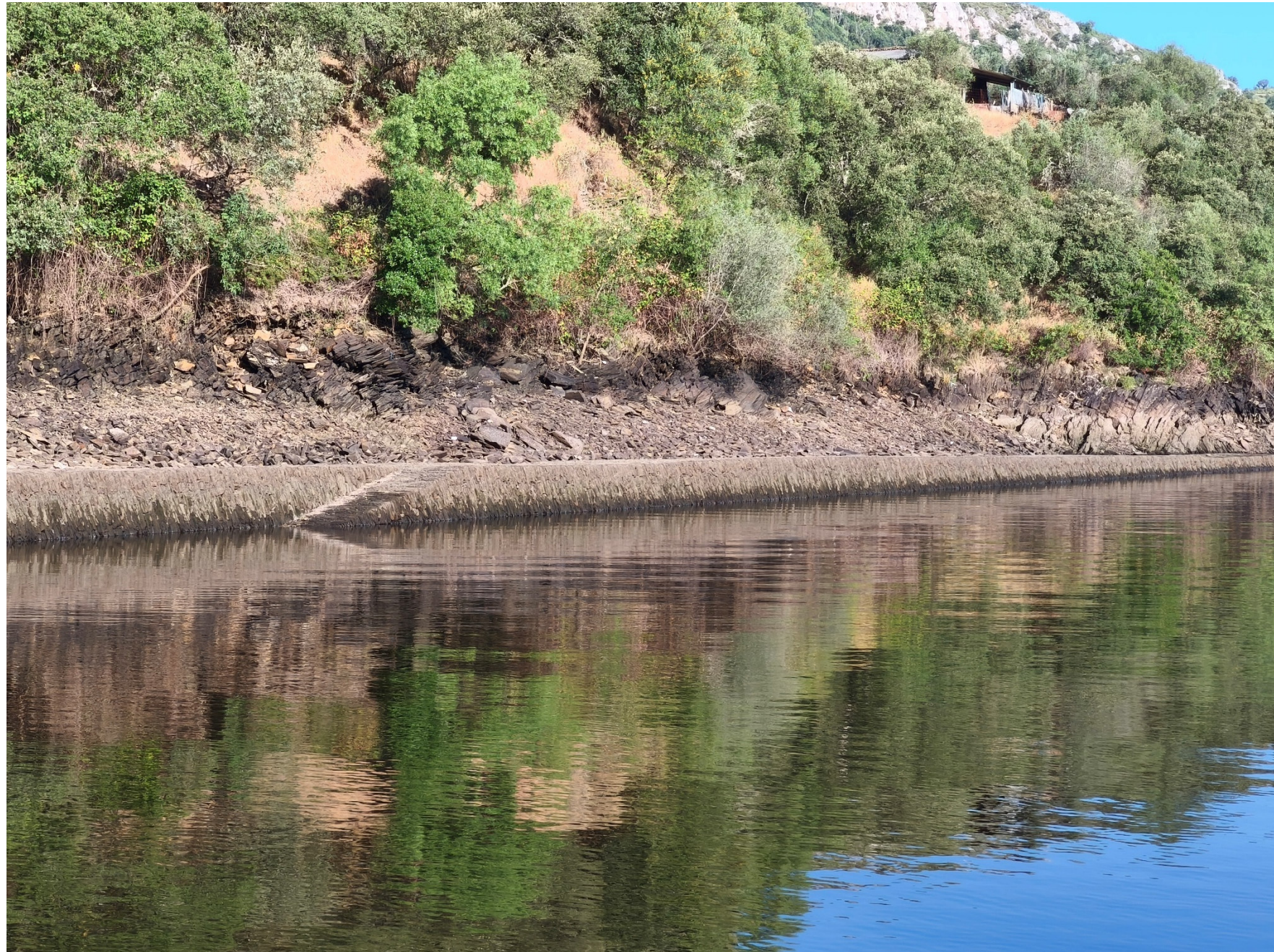
Figura 2. Muro de sirga visto do meio do rio.
