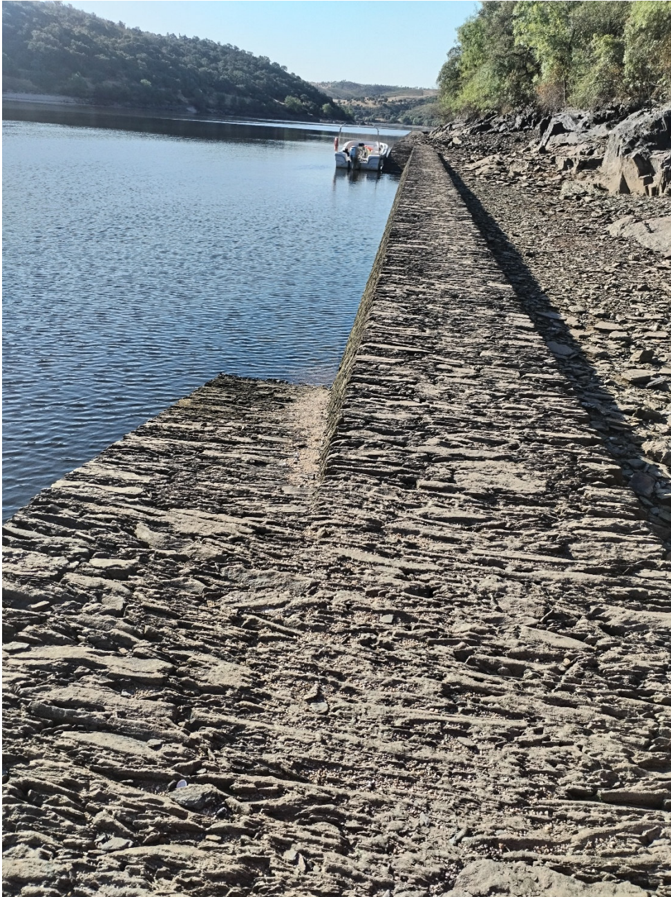
Figura 6. Acostagem para barcos ou acesso à base do muro.
