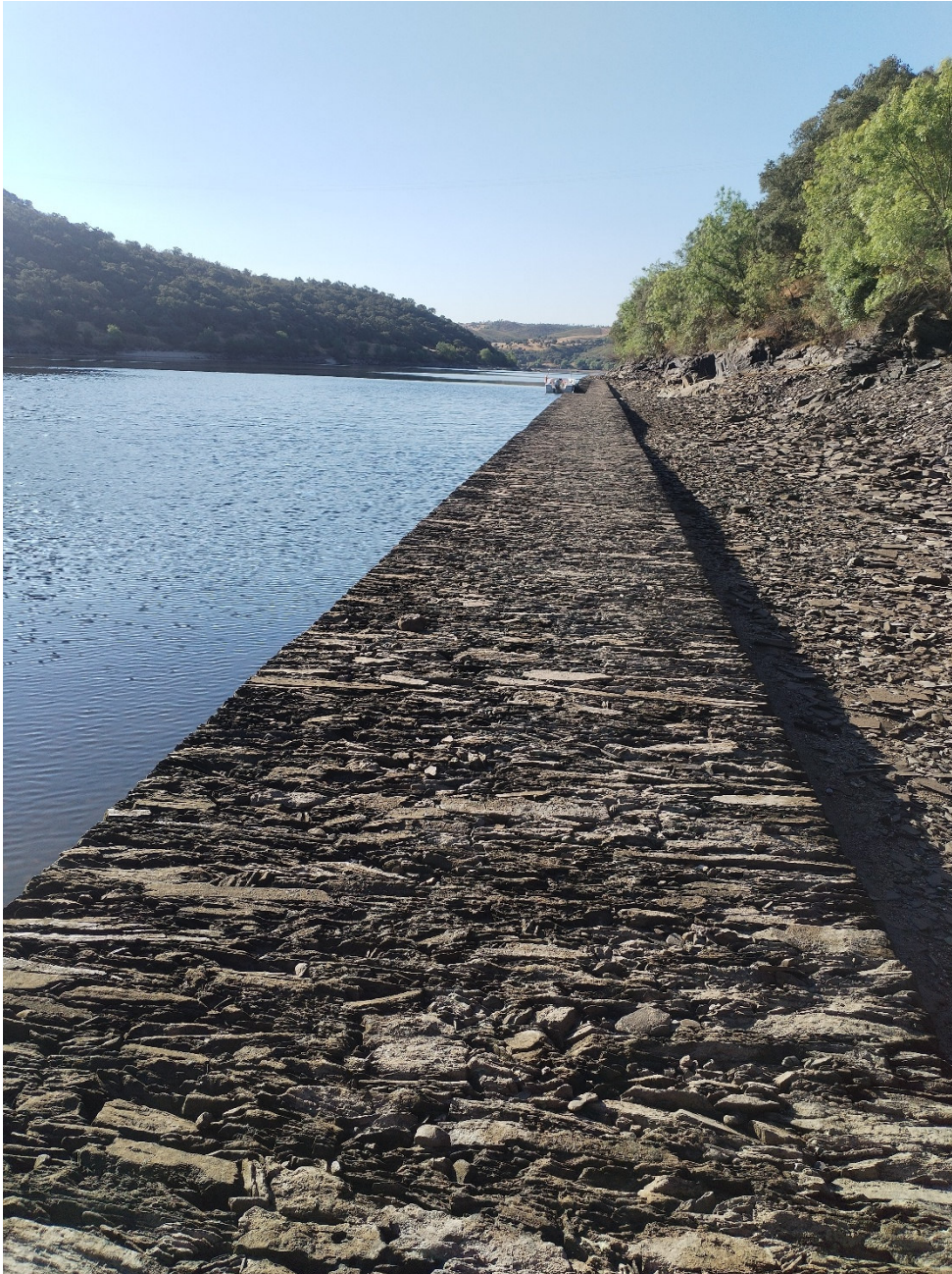
Figura 4. Perspetiva da estrutura vista de jusante para montante.
