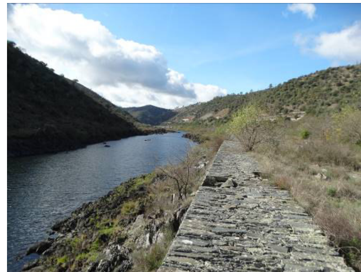
Figura 5. Muro de sirga de Gardete (fotografia: Francisco Henriques).
