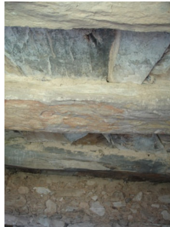
Figura 11. Placas de xisto a suportar o piso superior, Montes Matos (Alfrívada).
