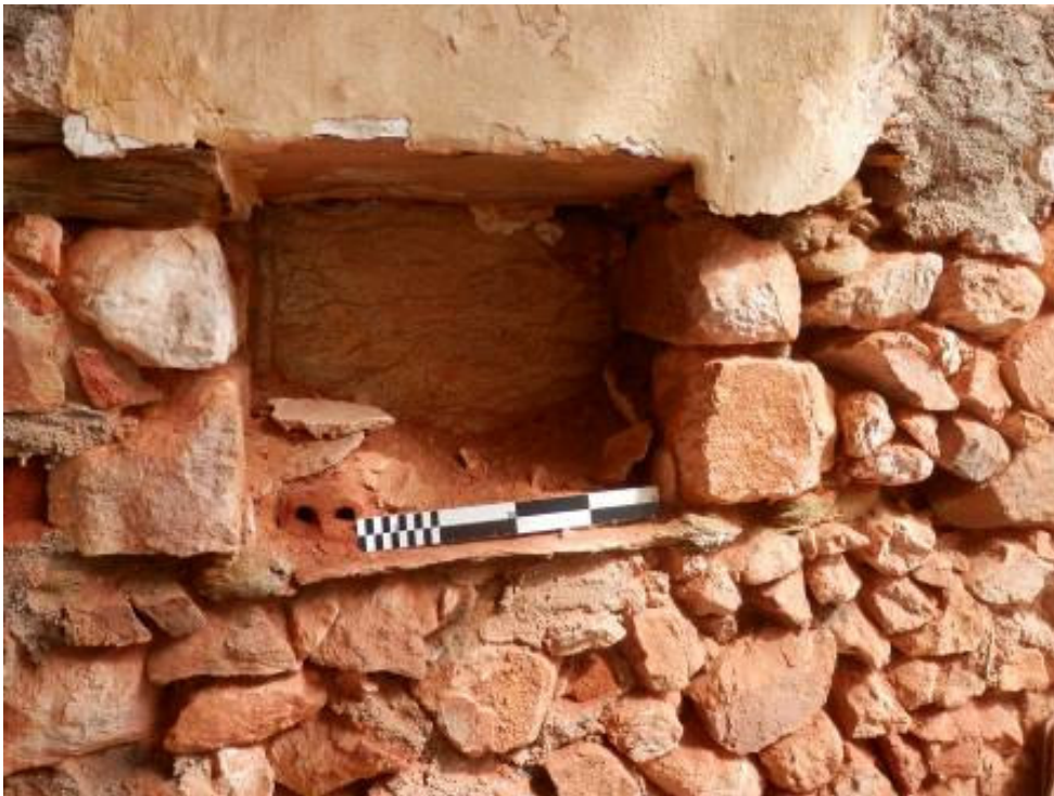
Figura 19. Pequeno nicho embutido na parede este da ruína ocidental.
