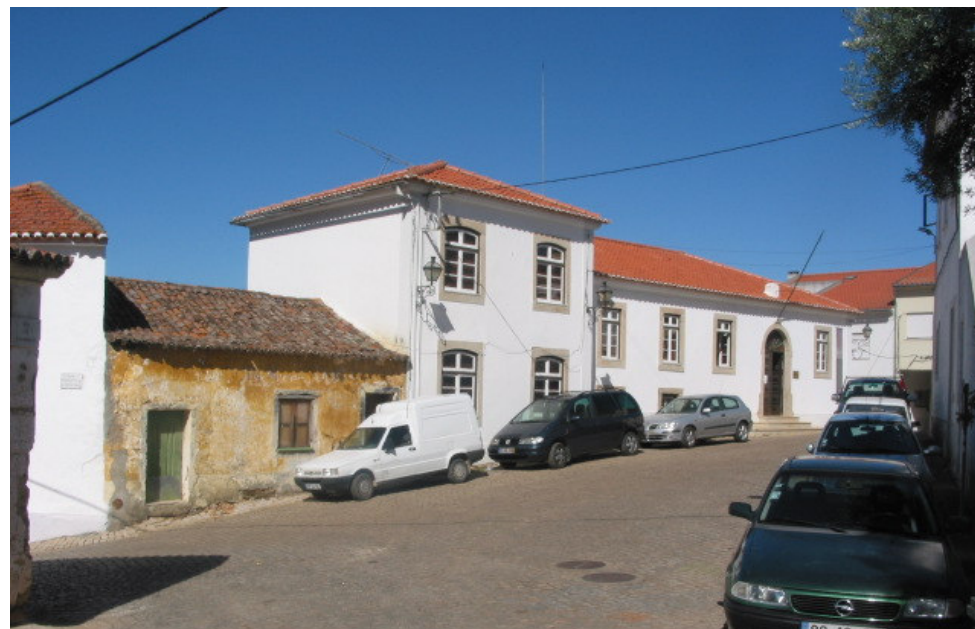
Figura 10. Imagem de conjunto no Largo da Praça em 2009, vista de oeste. O edifício amarelo entrou em ruína e neste trabalho passou a ser designado como ruína oriental (adossado ao Centro Municipal de Cultura de Vila Velha de Ródão) e ruína ocidental.
