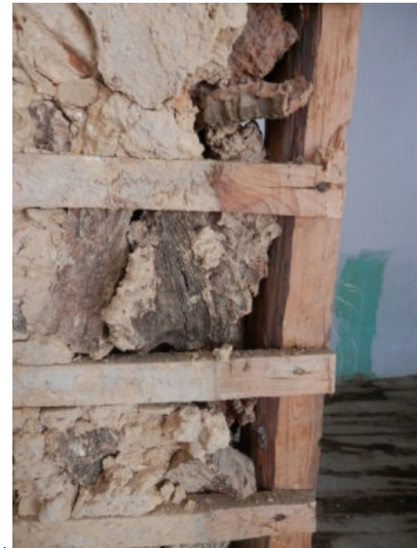
Figura 13. Pormenor de divisão interna com tabique, ou “francês” (preenchido com cortiça e argila) na casa de D. Felismina.
