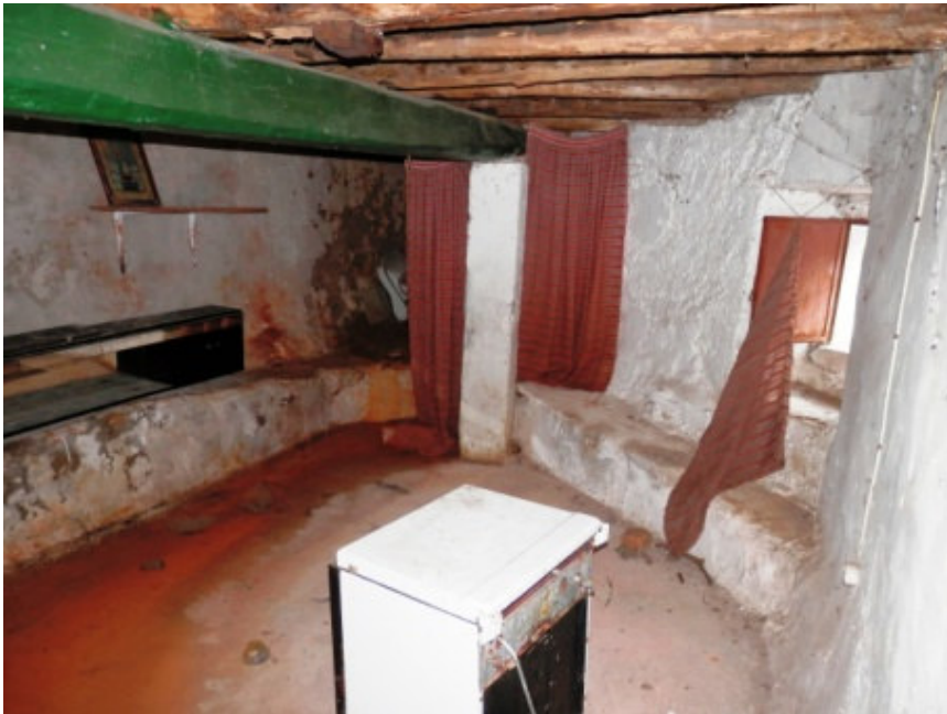
Figura 14. Poial adossado à parede na cave da casa de D. Leonor.
