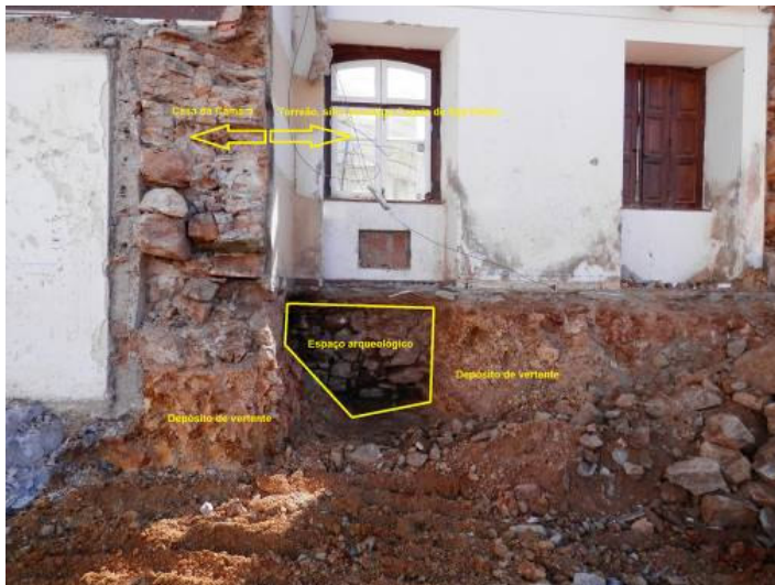
Figura 30. Implantação da estrutura negativa no contexto da obra, face sul.
