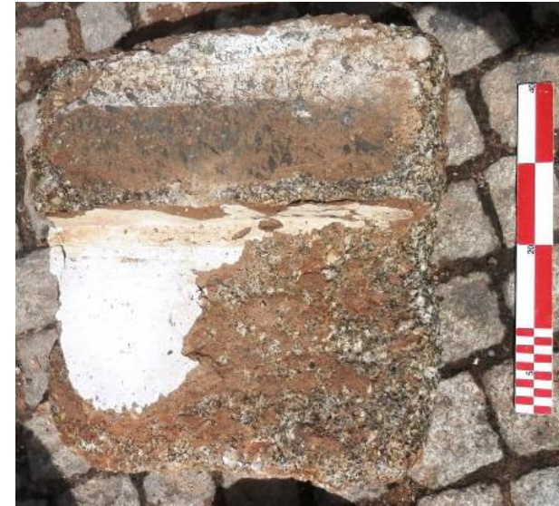
Figura 26. Ombreira de porta ou janela.
