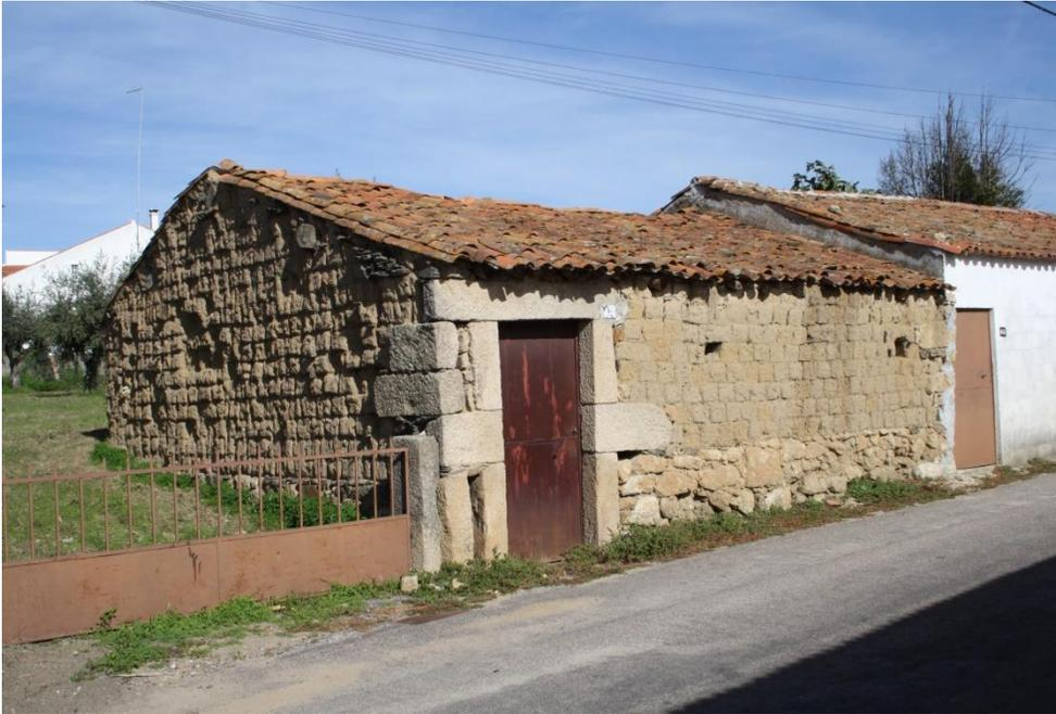
**Figura 6.** Vista da fachada de um palheiro construído com granito e tijolos de adobe (fotografia de Carlos Neto de Carvalho).
