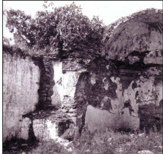
Figura 2. Interior da capela vendo-se parte da abóboda, o arco derruído e o altar colateral.
