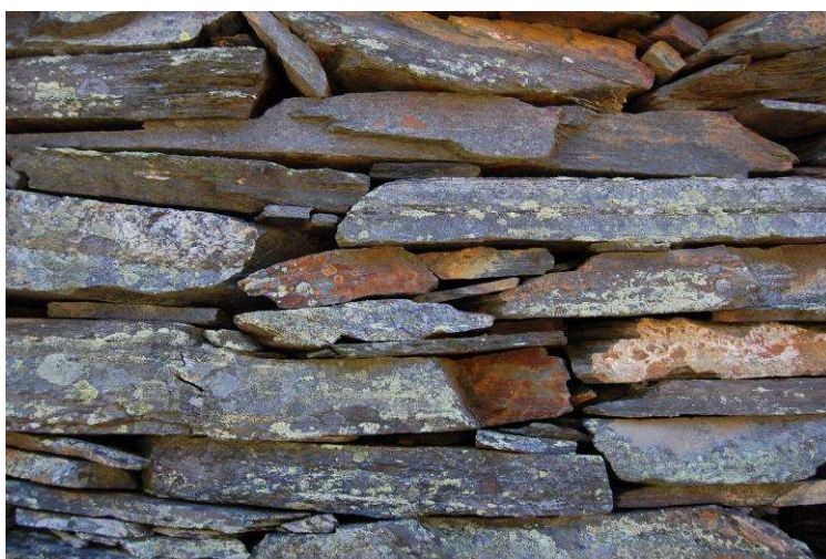
Figura 10. Pormenor da técnica construtiva: alvenaria de xisto em seco (fotografia de Lois Ladra).
