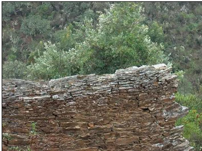
**Figura 14.** Parede de pedras de xisto, com argamassa argilosa, sem reboco.
