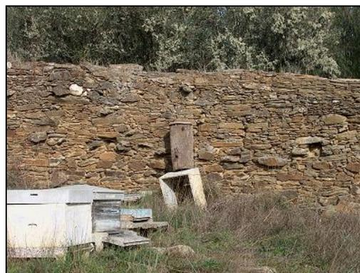
**Figura 9.** Aparelho com camadas horizontais bem definidas.
