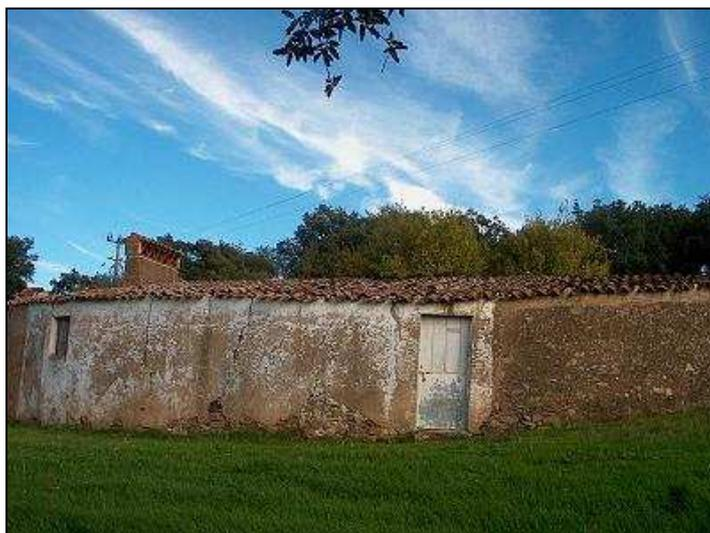
**Figura 15.** Parede de pedras de xisto e quartzito, com argamassa, rebocada com cal hidráulica e caiada na zona da casa.
