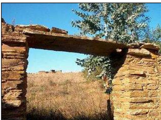
Figura 28. Lintel com buraco para sistema de fecho.
