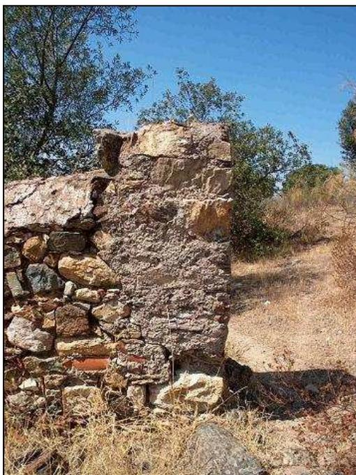
**Figura 27.** Porta com ombreira rebocada com cal hidráulica.
