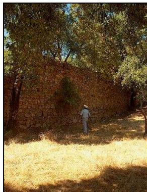
**Figura 56.** Muro apiário muito alto, com buracos a cerca de 2 metros que supostamente serviram para montar andaimes para construir a parte superior do muro.
