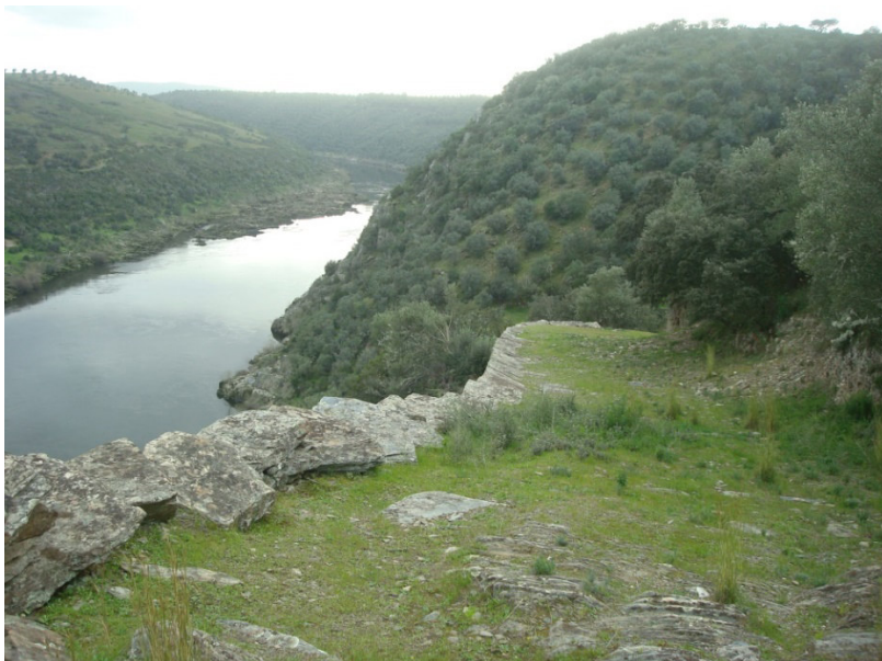
Imagem 5. Vista do rio para jusante.
