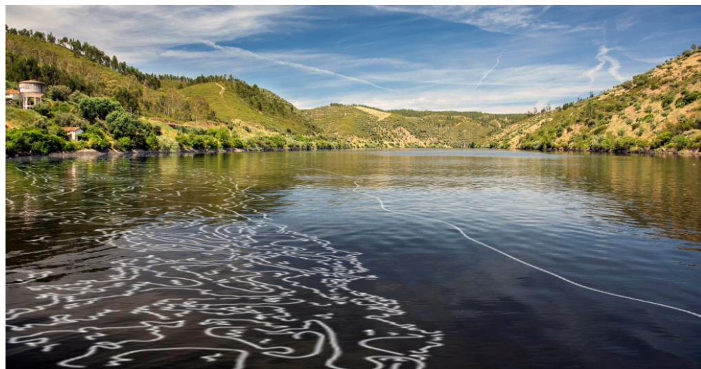
Figura 11. Instalação de superfície núcleo do Cachão do Boi – Fratel.
