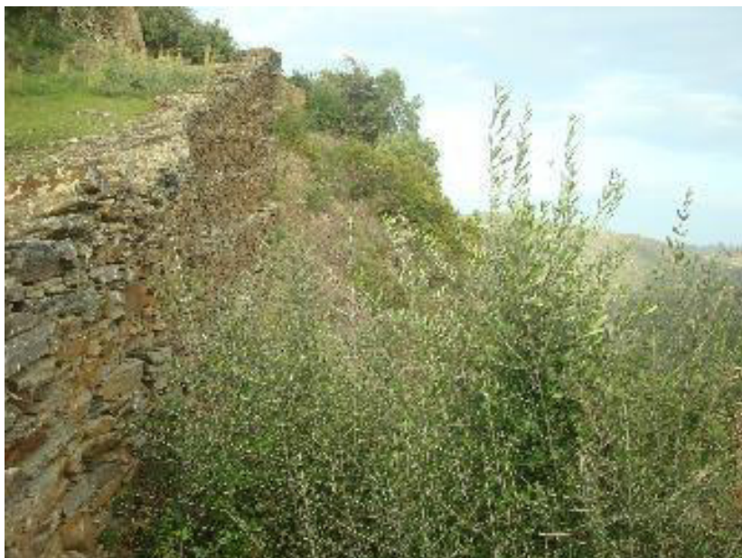
Imagem 6. Pormenor muro de suporte.
