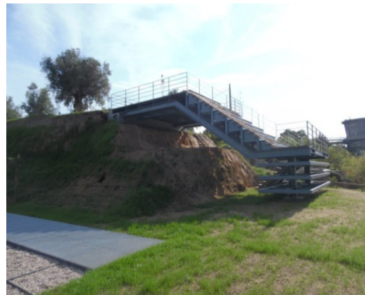
Imagem 10. Estrutura de proteção.
