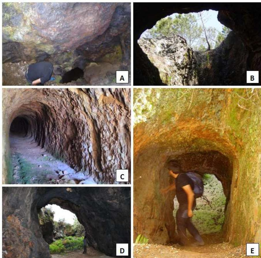
**Figura 21.** Vieiros de Salvador: **A**, abertura para um poço vertical no Vieiro do Almagre. **B**, abertura, em abóbada, para as galerias do Vieiro das Três Portas; **C,D,E**, Vieiro das Galhas: galeria, abertura em abóbada para galeria, e túnel de acesso à galeria do Vieiro das Galhas, respectivamente.
